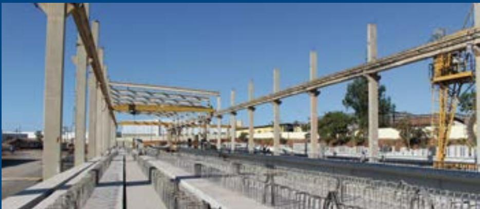
Os trabalhos foram iniciados no dia 20 de junho com a fabricação das vigas pré-moldadas que compõem a construção da nova ponte, no pátio da empresa contratada para a implantação.
