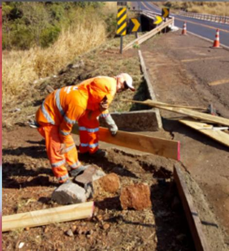
Vinte e duas equipes, chamadas de Equipes Cinzas, fazem a manutenção dos dispositivos de drenagem ao longo de todo o ano. Os funcionários limpam o sistema retirando galhos de árvore ou lixo e realizam reparos estruturais para garantir o bom funcionamento dos dispositivos de drenagem.
